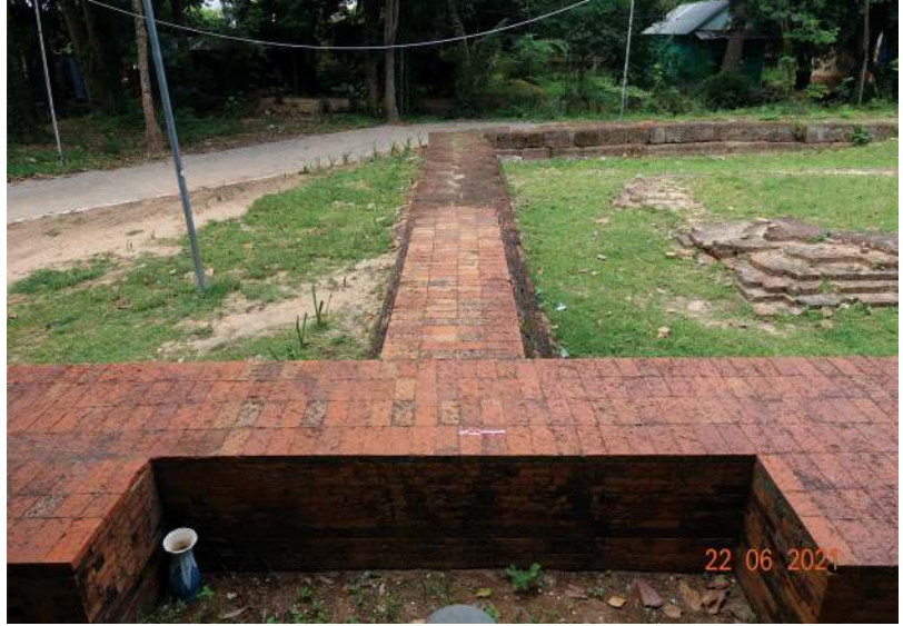
រូបលេខ១៤: ឥដ្ឋថ្មីជាច្រើនដុំដែលមានខ្នាតតូច ៣ស.ម. x ១០ស.ម. x ២០ស.ម. ប្រើប្រាស់សម្រាប់ជួសជុលរចនាសម្ព័ន្ធខូចខាតនៅប្រាសាទព្រះឥន្ទ្រកោសិយ
