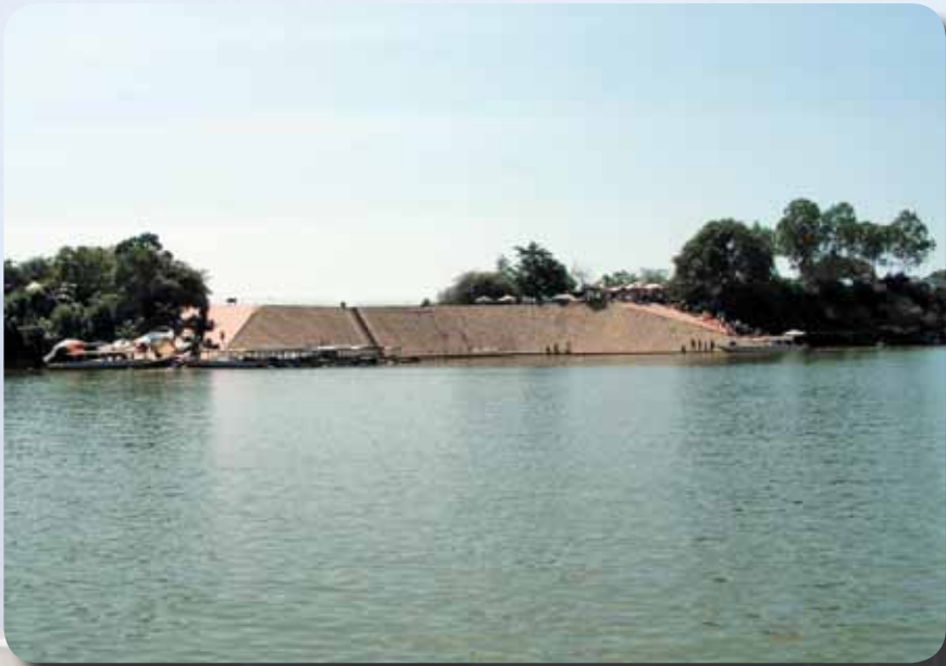
សំណង់ទ្វារទឹកបារាយណ៍ខាងលិច (មើលពីមុខ) សំណង់នេះមានតួនាទីសំខាន់ ក្នុងការងារ បញ្ជាលទ្ធិកទុកក្នុងបារាយណ៍ និងបង្ហូរទឹកស្រោចស្រពនៅរដូវប្រាំង
