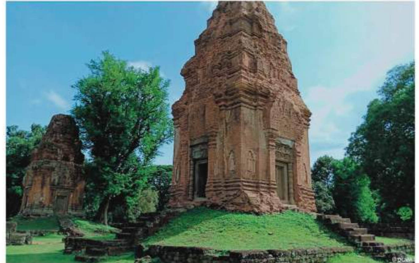
ប៊ែមឥដ្ឋលេខ៦ គឺស្ថិតនៅបរិវេណខាងលិចផ្នែកខាងជើងនៃប៊ែមឥដ្ឋលេខ៧ប្រាសាទបាគង។ ប៊ែមនេះមានស្ថានភាព ឥដ្ឋពុកផុយ និងរលុះឥដ្ឋខ្លាំង។ ដើមឈើ និងឫសឈើបានចាក់ស្រែចូលក្នុងស្រទាប់ឥដ្ឋបង្កឲ្យមានការរលុះរលួយ ដោយអង្វើ។ ប៊ែមទាំងមូលបានធ្វើការពង្រឹង និងជួសជុលឡើងវិញក្នុងឆ្នាំ២០១៥ ហើយបញ្ចប់នៅចុងឆ្នាំ២០១៧។ ការជួសជុលធ្វើឡើងដោយផ្នែកនៅត្រង់ទីតាំងរក្សាខ្លួនខាងប៉ុណ្ណោះ ព្រមទាំងបិទភ្ជិតប្រហោងរន្ធតូចៗនៅលើ ជញ្ជាំង។
