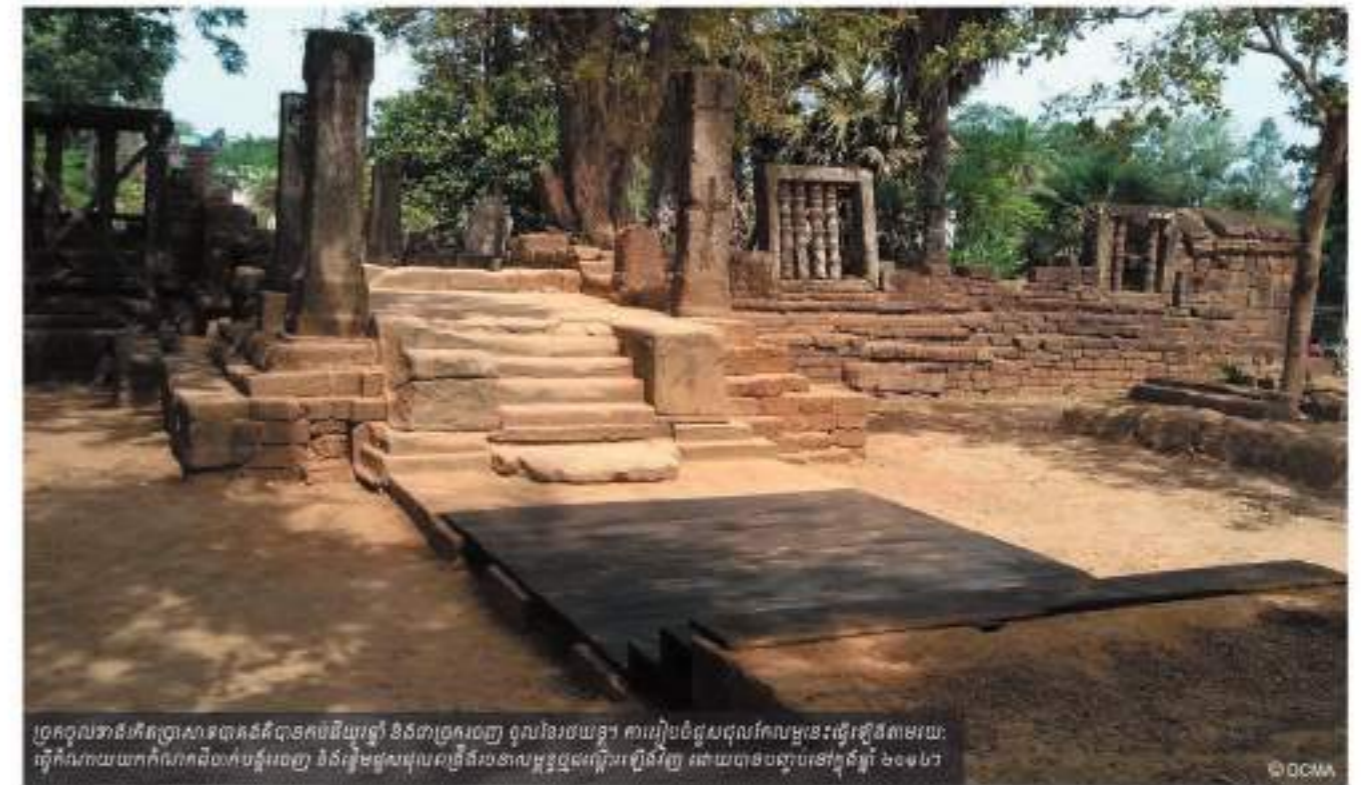
ប៊ែមឥដ្ឋលេខ៦ គឺស្ថិតនៅបរិវេណខាងលិចផ្នែកខាងជើងនៃប៊ែមឥដ្ឋលេខ៧ប្រាសាទបាគង។ ប៊ែមនេះមានស្ថានភាព ឥដ្ឋពុកផុយ និងរលុះឥដ្ឋខ្លាំង។ ដើមឈើ និងឫសឈើបានចាក់ស្រែចូលក្នុងស្រទាប់ឥដ្ឋបង្កឲ្យមានការរលុះរលួយ ដោយអង្វើ។ ប៊ែមទាំងមូលបានធ្វើការពង្រឹង និងជួសជុលឡើងវិញក្នុងឆ្នាំ២០១៥ ហើយបញ្ចប់នៅចុងឆ្នាំ២០១៧។ ការជួសជុលធ្វើឡើងដោយផ្នែកនៅត្រង់ទីតាំងរក្សាខ្លួនខាងប៉ុណ្ណោះ ព្រមទាំងបិទភ្ជិតប្រហោងរន្ធតូចៗនៅលើ ជញ្ជាំង។
